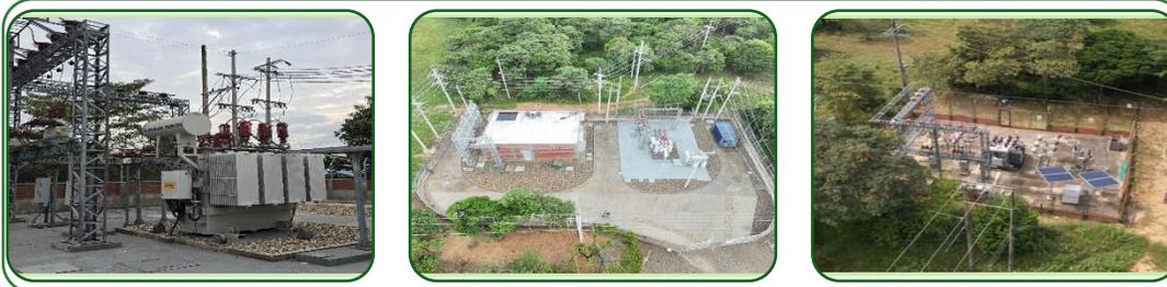
Reposición de 5.50 km de red aérea de un alimentador 13.8 kV para reconfiguración en doble nivel con la red de 34.5 kV construida.
