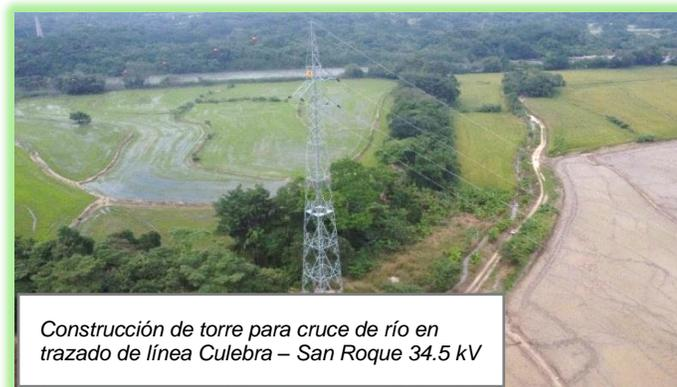
Ilustración 38. Foto 3 Proyecto Nueva Línea La Culebra – San Roque 34.5/13.8 kV
