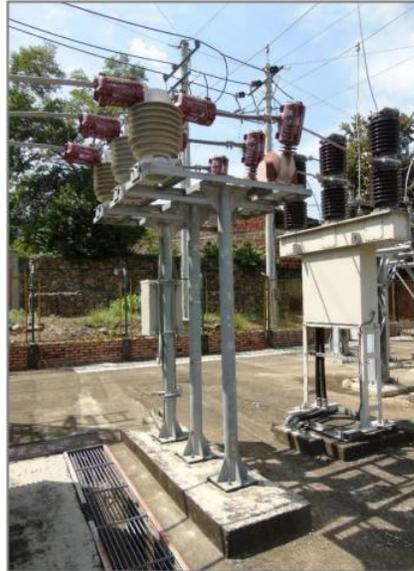
*Ilustración 32. Foto 1 Transformadores de corriente antiguos*
