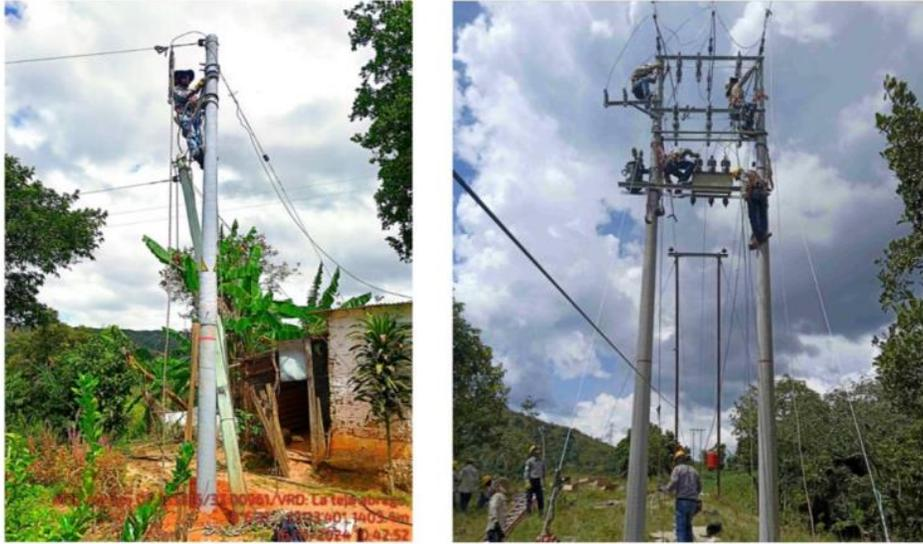
Ilustración 25. Foto 2 hincado de poste e instalación de transformador
