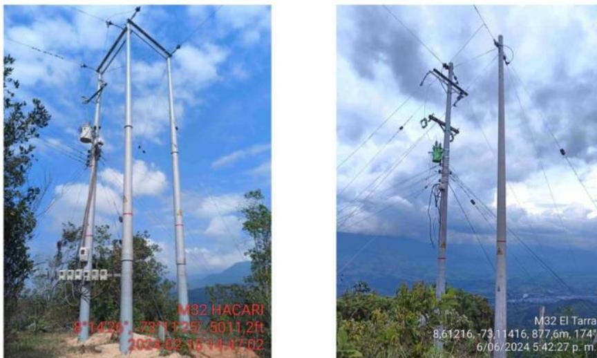
*Ilustración 24. Foto 1 hincado de poste e instalación de transformador*
