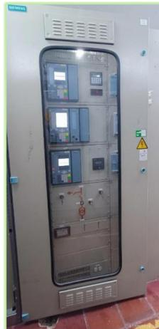
Ilustración 31. Foto 2 nuevo tablero de control y protección SE San Mateo
