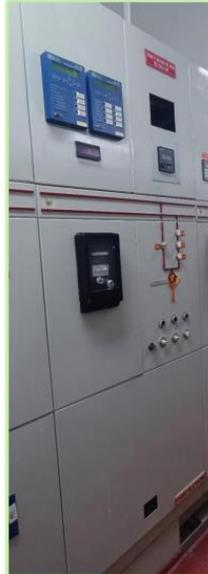
Ilustración 30. Foto 1 anterior tablero de control y protección SE San Mateo
