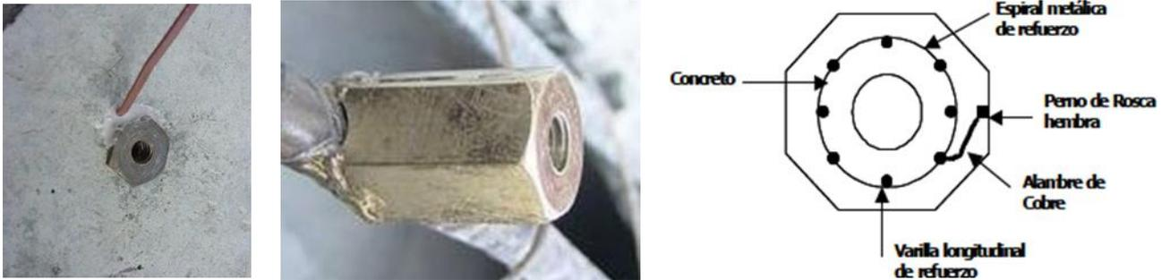
**Figura 6. Pernos y conectores de puesta a tierra para postes**
