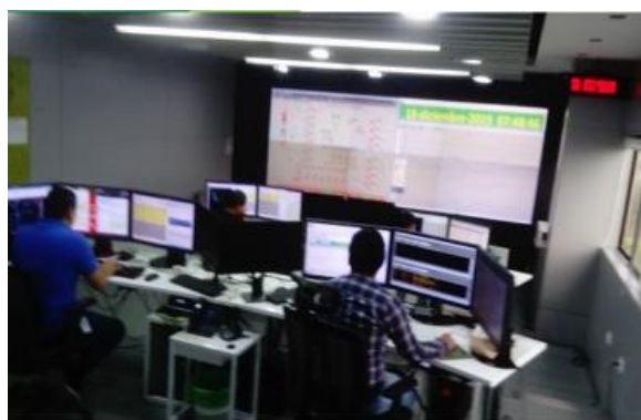
Fotografía 2. Centro de Control CENS
