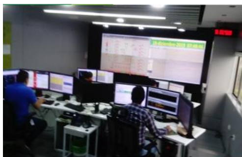
Figura 22. Centro de Control CENS
