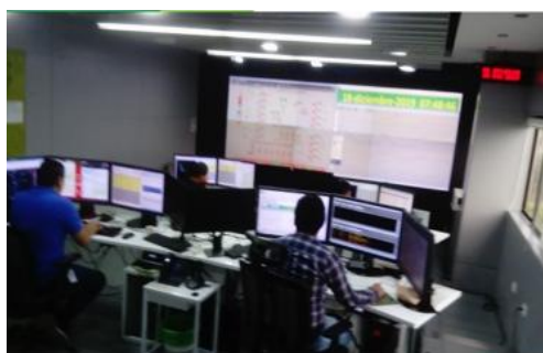
Figura 21. Centro de Control CENS
