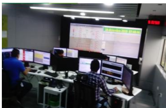
Figura 21. Centro de Control CENS
