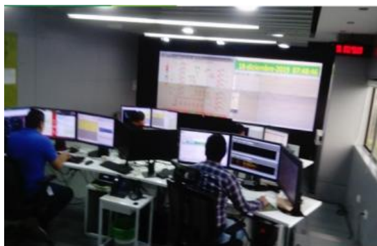
Figura 21. Centro de Control CENS
