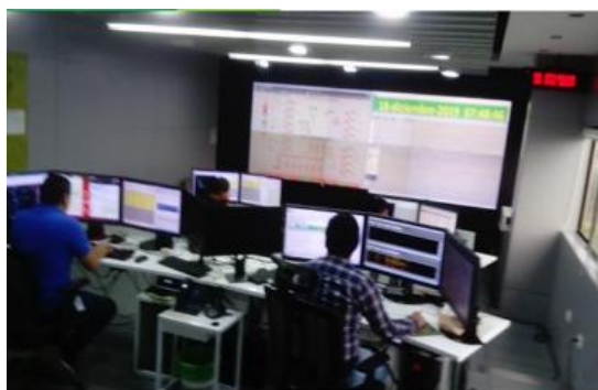
Figura 21. Centro de Control CENS
