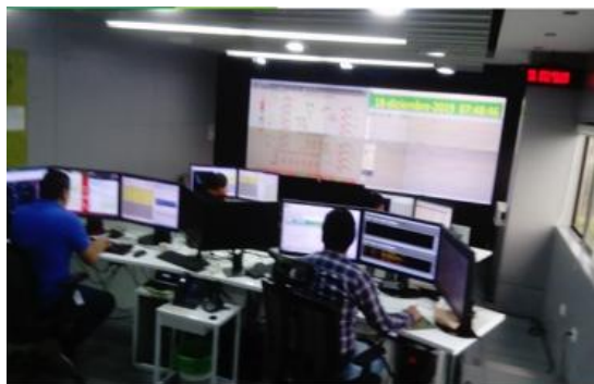
Figura 21. Centro de Control CENS
