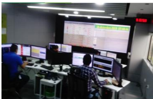
Figura 24. Centro de Control CENS
