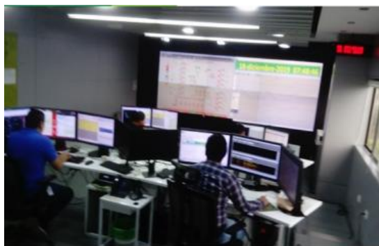
Figura 24. Centro de Control CENS
