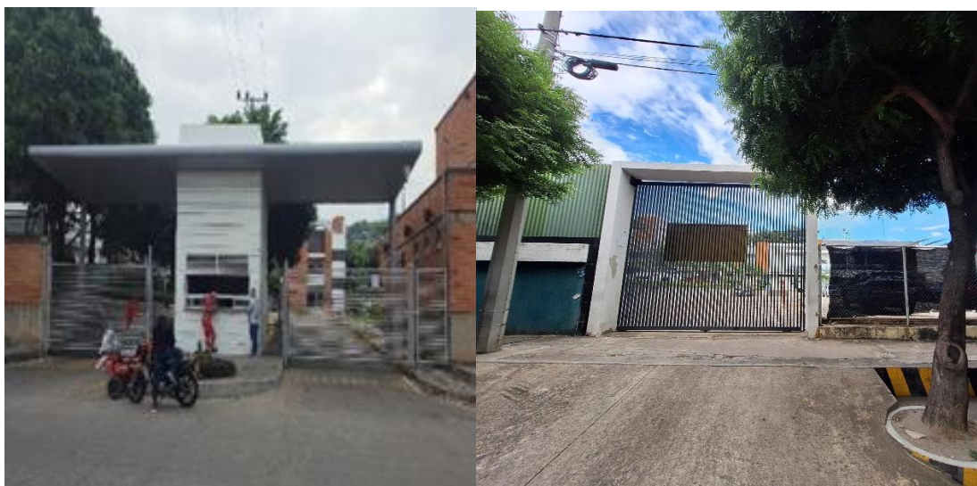
Figura 8. Porterías No. 2 y 3
