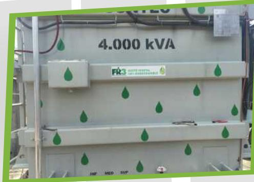
Implementación de tecnologías alternas al uso de componentes primarios derivados de hidrocarburos como la adquisición de transformadores con medio aislante en aceite vegetal con alto potencial biodegradable
